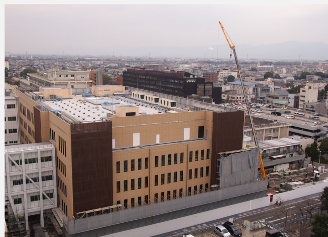
H26.12.24 県立中央病院屋上から撮影
